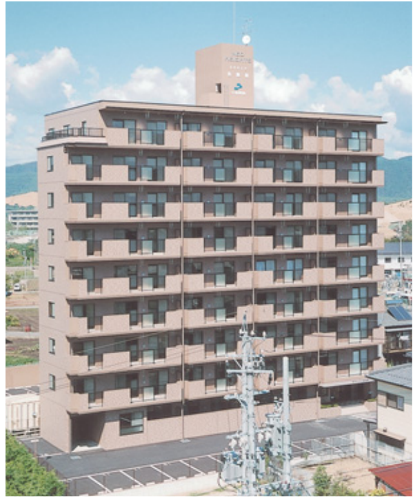
ネオハイツ各務原新築工事 施主/大和団地㈱ 施工/株浅沼組
