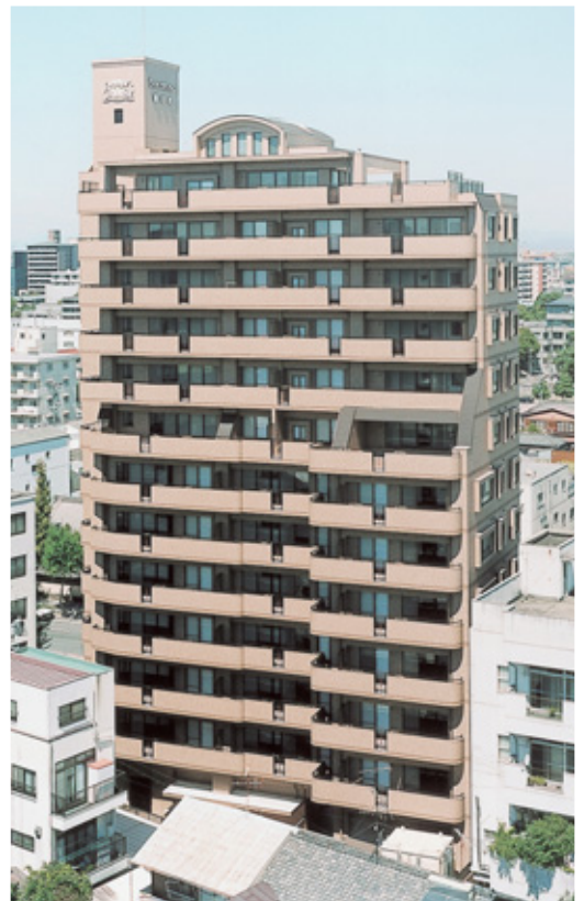
ライオンズマンション飯田町新築工事 施工/株松村組
